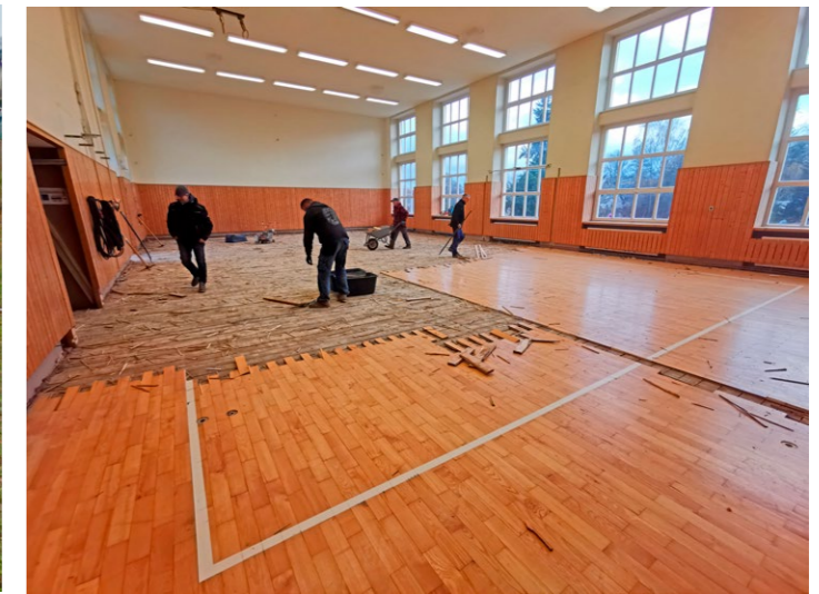
Ausbau des alten Parkettbelages
