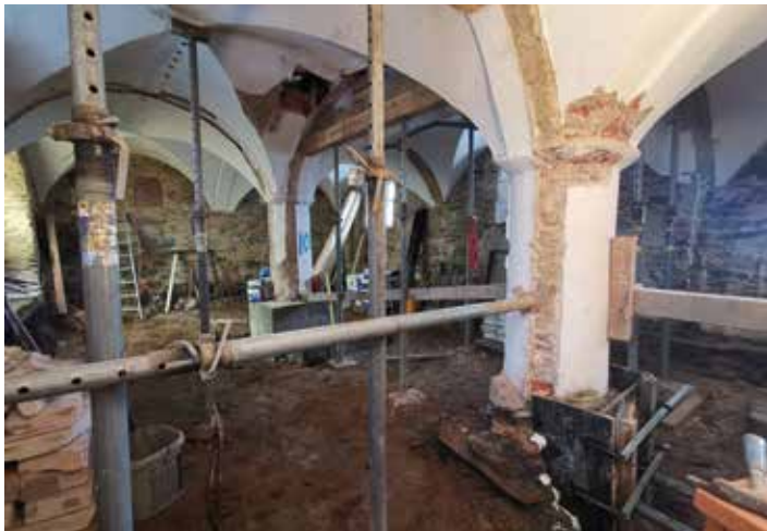
Sicherungs- und Abstützarbeiten im Erdgeschoss
