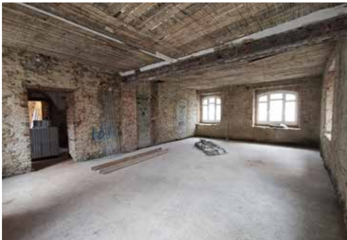
Der Raum des Begegnungszentrums nach der Entkernung mit neu eingebauter Bodenplatte
