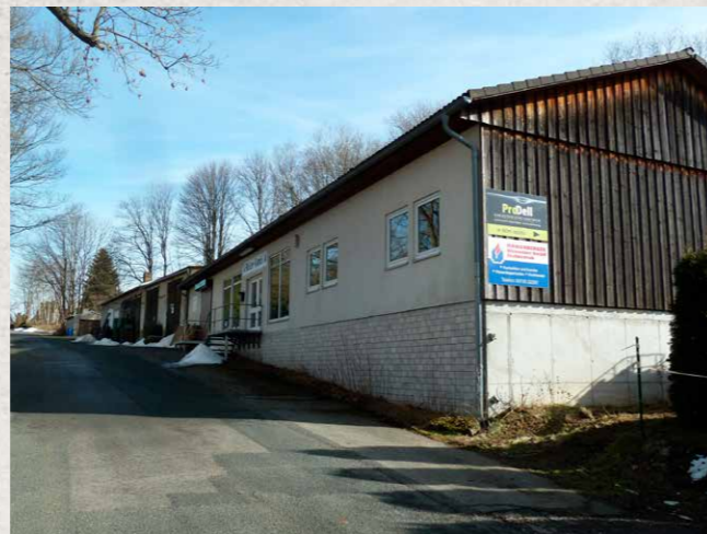
Teil der Fabrikanlage mit Rest der Spinnhalle in Shedbauweise, 02/2021
