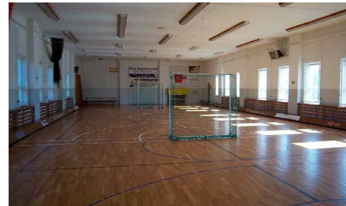
Die Turnhalle vor der Sanierungsmaßnahme mit altem Parkett-Sportfußboden
