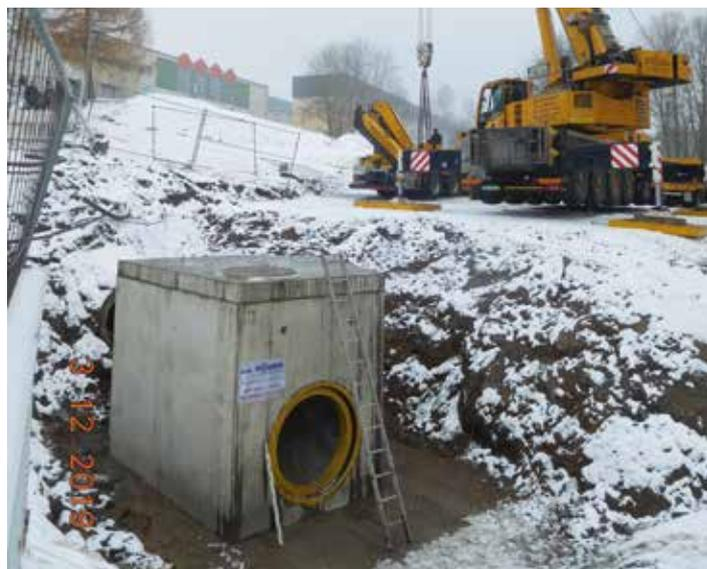
*Setzen des Vereinigungsbauwerkes der Zuflüsse mit Durchmessern DN 1200 und DN 600*
