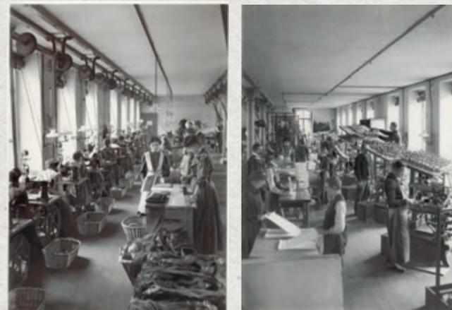
Aus den neuen Fabrikinnenräumen haben sich aus den Jahren 1912/13 zwei anschauliche Aufnahmen erhalten, welche die zwei Produktionslinien, einerseits die Strumpferstellung und andererseits die Posamentenherstellung mit dem Galonieren, zeigen.
