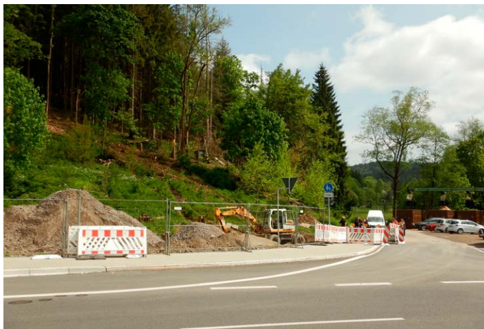
Wanderrastplatz Kniebreche – Auskoffnung Platz und Einbau Frostschutzmaterial
