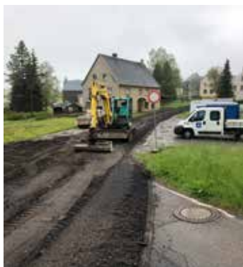
Zunächst wurde die alte Asphalt-Deckschicht abgetragen
