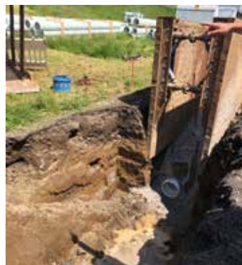
Austausch des vorhandenen Regenwasserkanales
