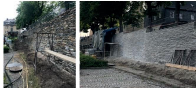
Ansicht der Stützmauer nach Beginn und kurz vor Abschluss der Instandsetzungsarbeiten
