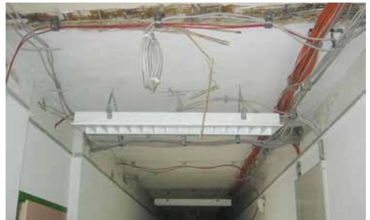
In den Zimmern und Fluren wurden zahlreiche Kabel, unter anderem für die vorbereitenden Installationen im Rahmen des „DigitalPaktes“, verlegt.
