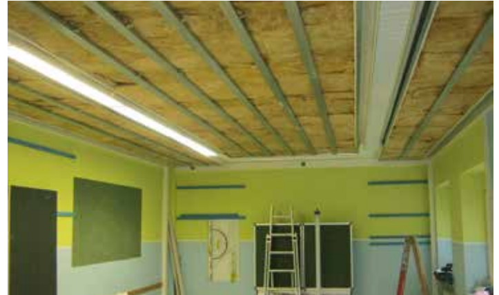
An den Decken der Klassenzimmer wurden schallmindernde Elemente eingebaut.
