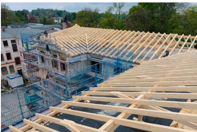
Baustelle Baldauf-Fabrik, Am Roten Turm 1 in Marienberg
