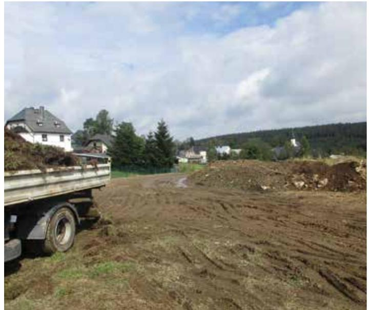
Zunächst wird das Gelände durch Auffüllen von Erdmassen reguliert, um den Platz herzurichten.
