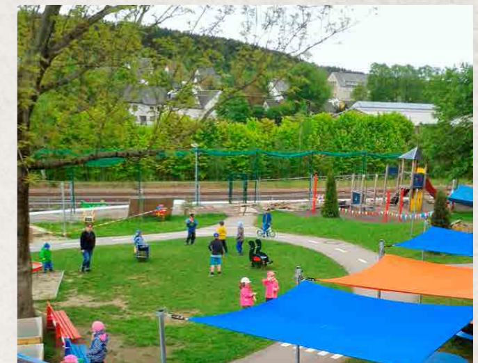
Das Haus während der Bauphase und die fertigen Außenanlagen.
