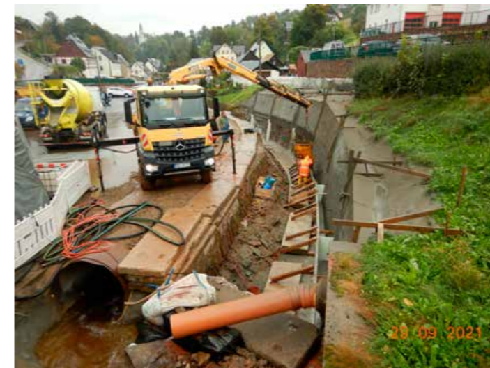
Betonieren der Fundamente
