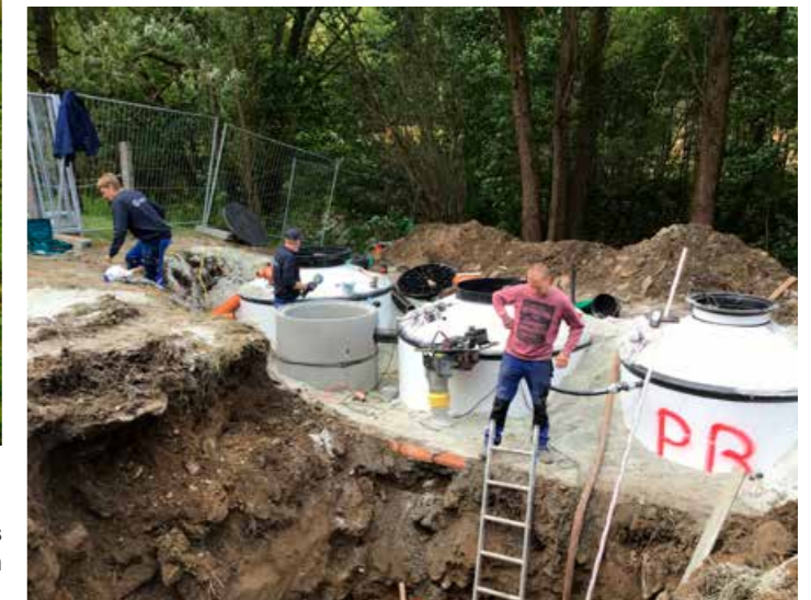
Erdeinbau neben dem Standort der alten Kläranlage
