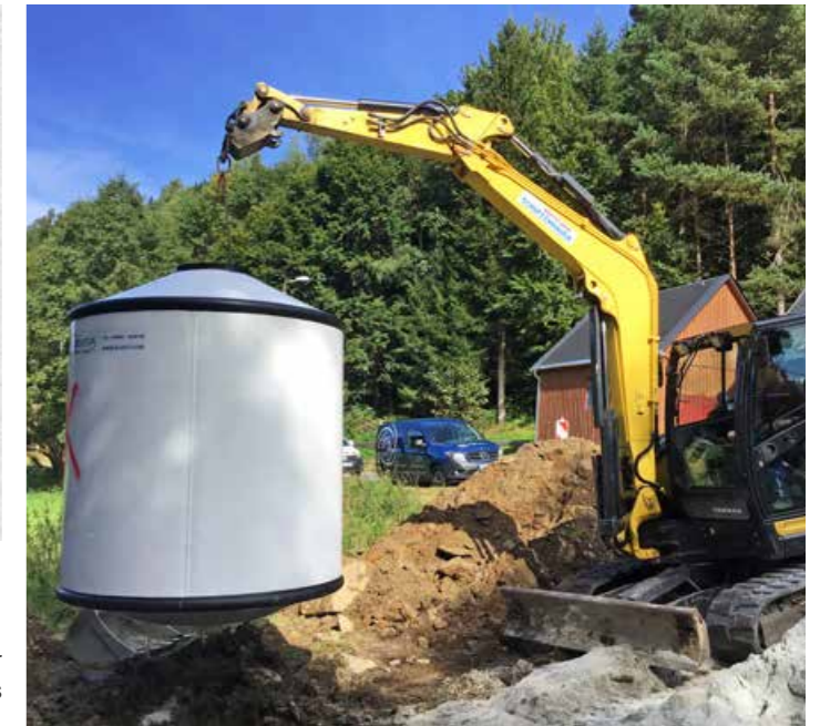
Einheben eines Beckens
