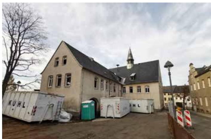
Zunächst wurde der Bereich hinter dem ehemaligen Rathaus von Bewuchs beräumt und der Mutterboden seitlich gelagert. Auf die entstandene Freifläche wurde Frostschutz aufgebracht, um eine ordentliche Fläche für die Baustelleneinrichtung zu schaffen.
