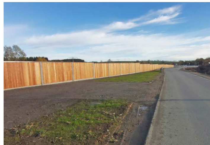
Die fertige Lärmschutzwand entlang der B 174
