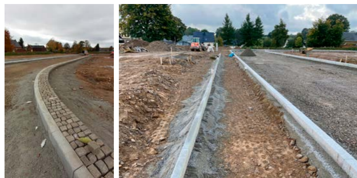
Die Arbeiten zur Verlegung der Borde für die Straße und den künftigen Gehweg sind nahezu abgeschlossen
