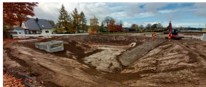
Blick in das entstehende Regenrückhaltebecken
