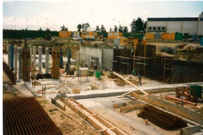
Die Technikerebene entsteht, erste Wände des Außenluftkanals und die Stützen in der Lüftungszentrale sind bereits zu erkennen
