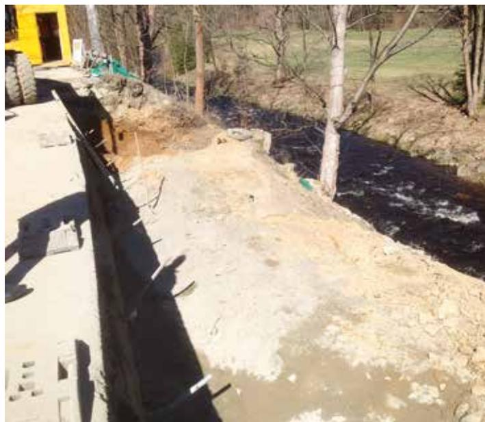
Baugrube des Randbalkens mit Baugrubensicherung (Spritzbetonwand)
