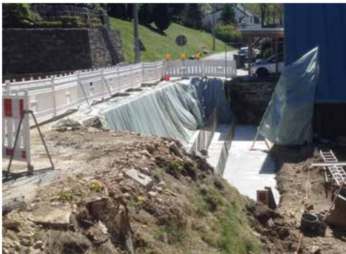
Herstellung der Fundamente für die Stützmauersegmente im Bereich Hausnummer 19
