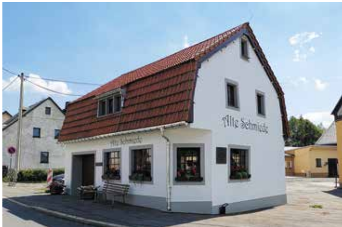
Der Schriftzug „Alte Schmiede“ zielt nun wieder das Gebäude
