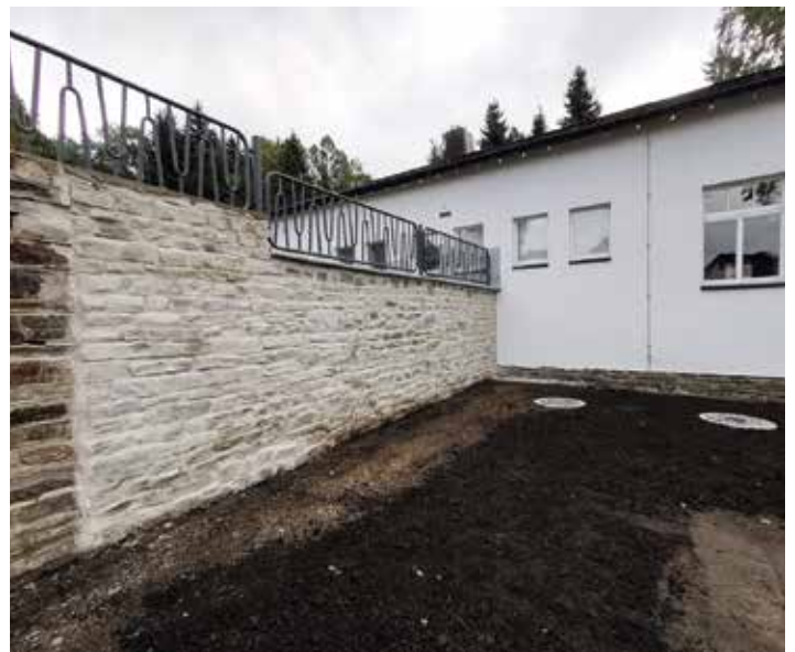
Die neu errichtete Winkelstützwand
