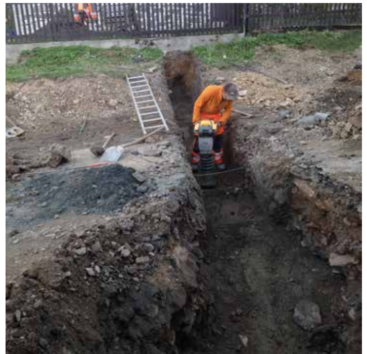
Der Leitungsgraben eines Hausanschlusses wird verdichtet
